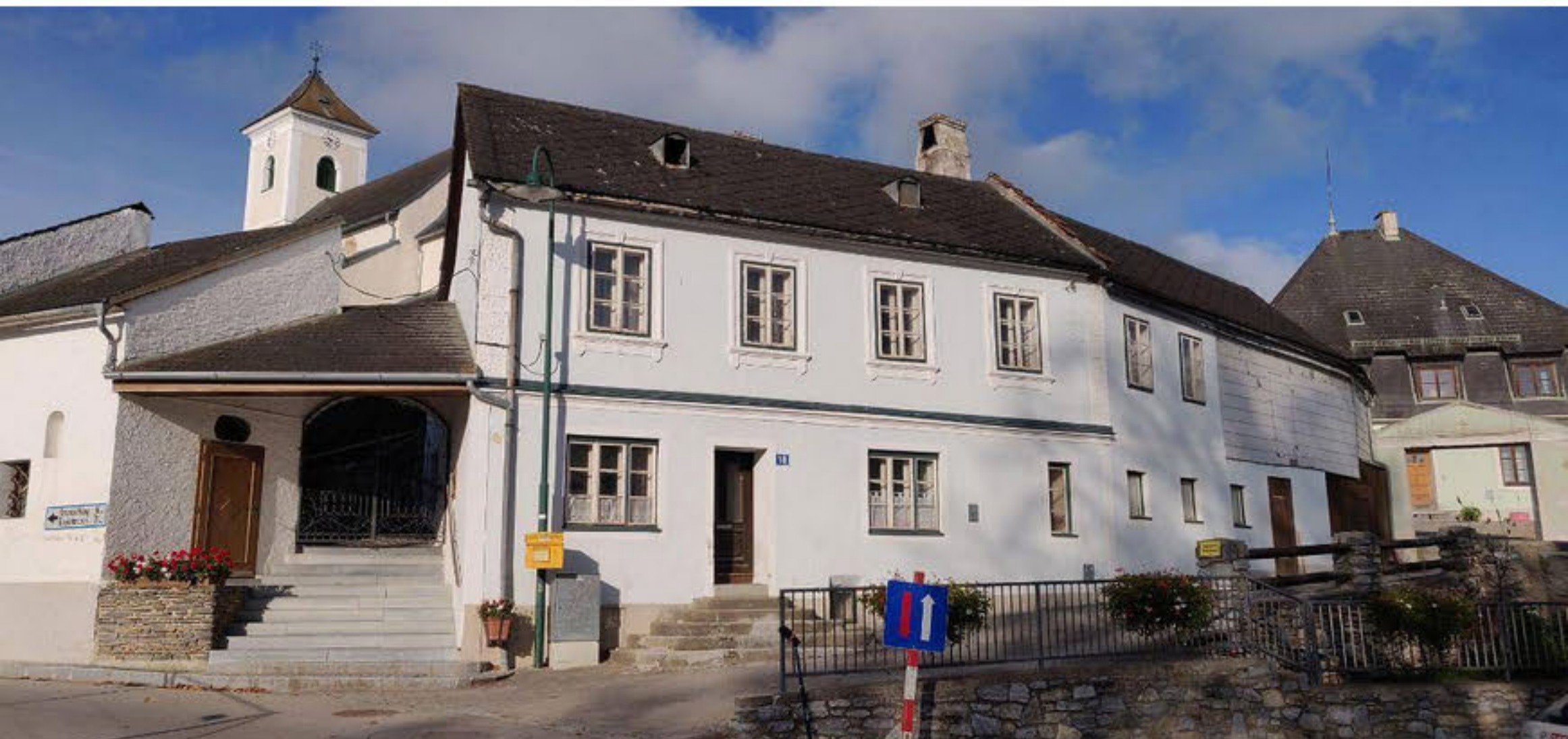
Dieses Haus im Ortskern der Teilgemeinde Purk wurde vor Kurzem an einen Tiroler verkauft. Davor stand es 15 Jahre lang leer.
