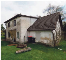
Dieses Objekt in Reingers wird derzeit saniert.
